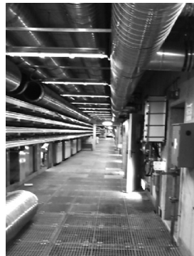
写真3 5) 海面下の基礎ケーソン内にある維持管理用通路
