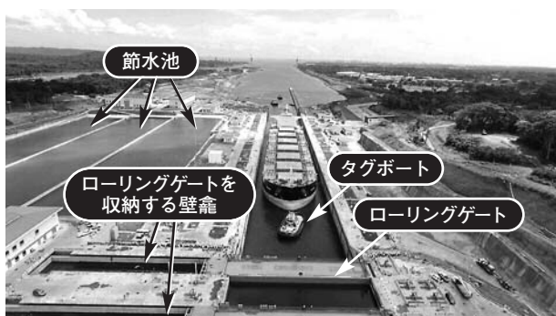
写真1 アグア・クララ閘門を通過するタンカー （パナマ運河庁資料より）
