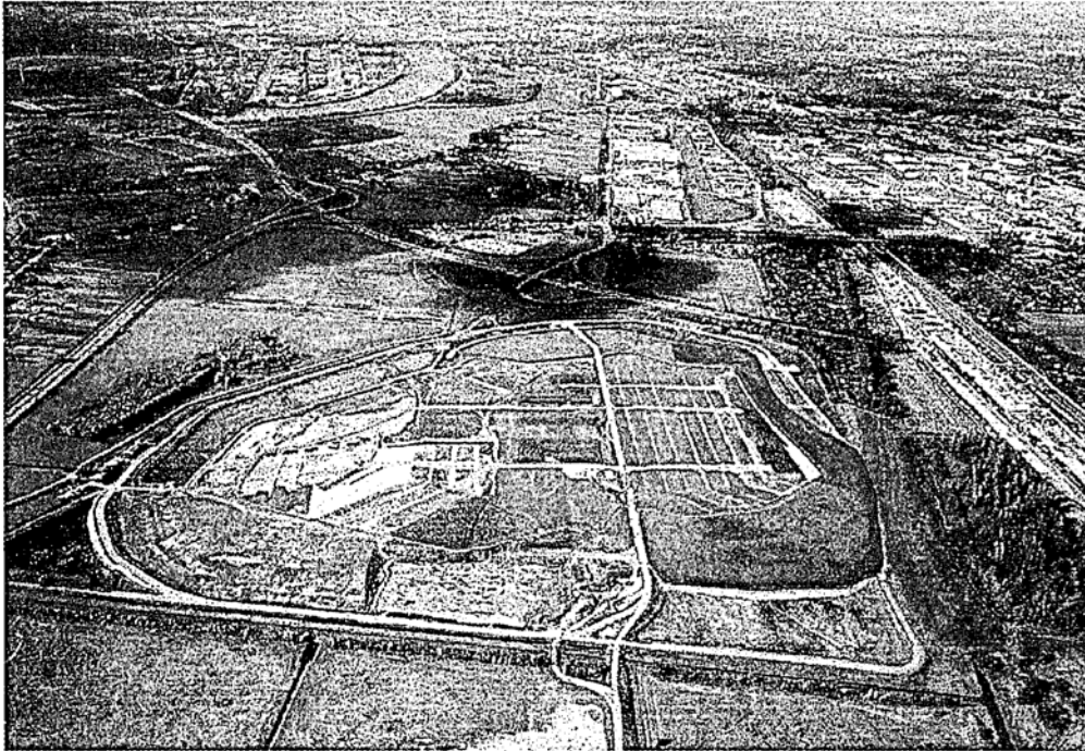
ハンブルグ港のフェルトホッフ土砂処分場（東側上空より）
