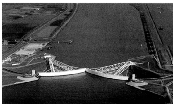
マエスラント堰
