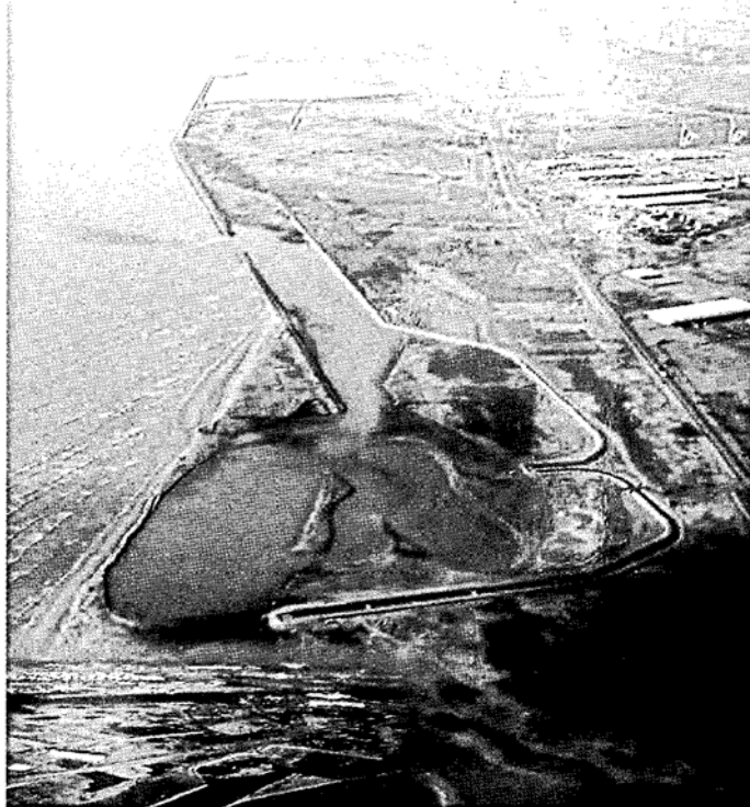
干潟安定再生工事
