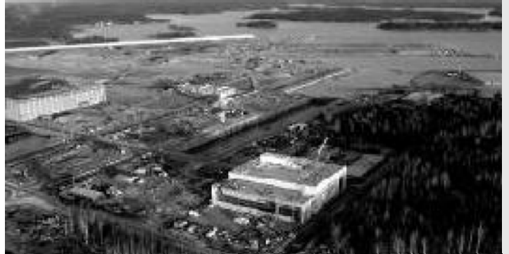
写真2 南西方向より見たウォサーリ地区。港湾地区の北東部に防音壁が設置されている（写真左上）
