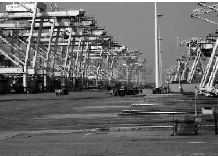
ロッテルダム港(ECTデルタターミナル)における自動化されたターミナルの状況(中央手前はAGV:自動搬送台車)
