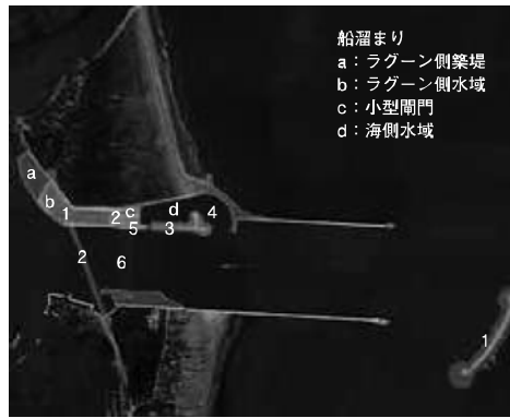
写真2 キオジャ水路での建設状況
