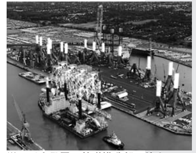
洋上風力発電の基礎構造部の積出し
