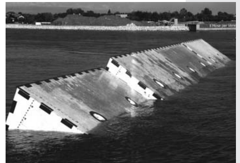
写真1 浮上したフラップゲート
