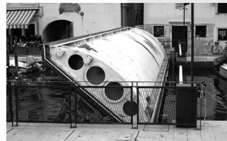
写真1 ベビー・モーゼの回転開閉式ゲート
