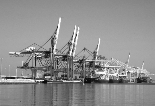
PORT2000の開発が進むルーアール港
