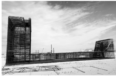
写真2 上部工の鉄筋組み
