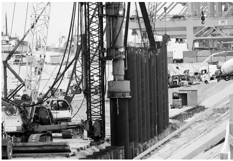
写真1 鋼管杭の打設状況
