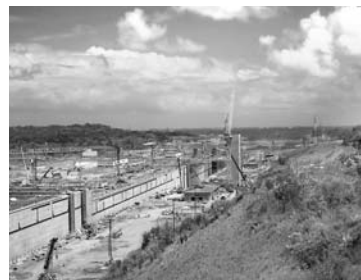
拡張工事現場
