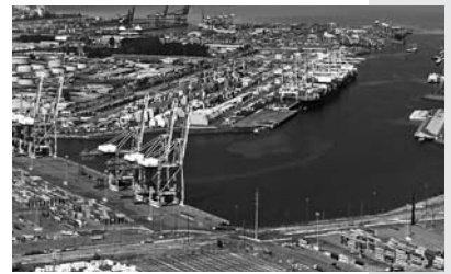
写真2 タコマ港のCT群 出所：タコマ港HP
