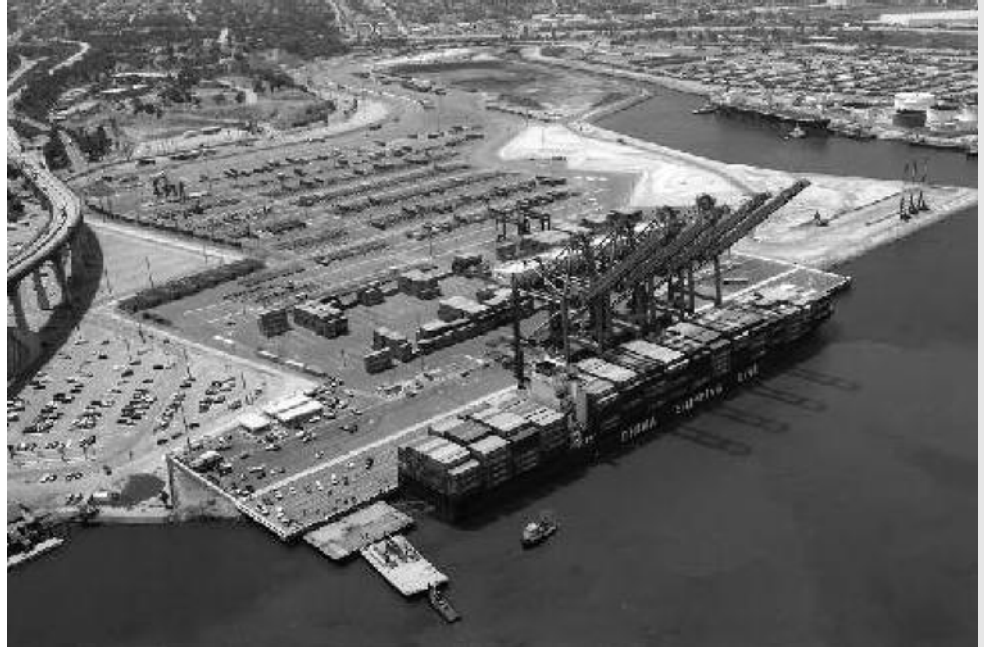
写真1 第100パースで代替電力供給を受けるAMP船（タグに押されているのが変圧用バージ）
