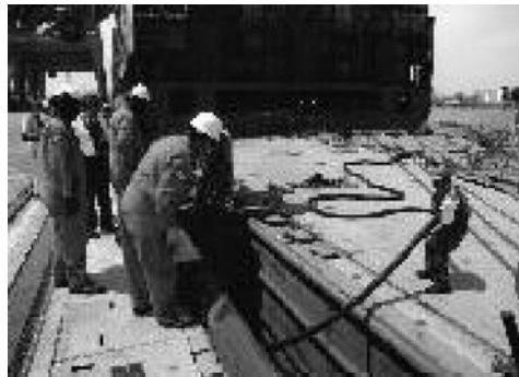
写真2 電源ケーブルを栈橋下部に設置されたコンセントに接続しているところ
