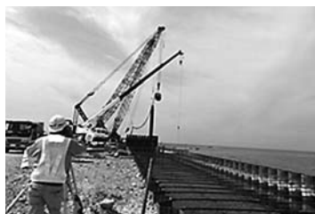
建設工事の状況（2015年9月撮影）
