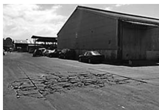
ホニアラ港の既存国際埠頭 ヤードなどで舗装が損傷
