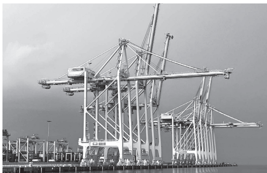
図2 自動化されたガントリークレーン (VICT)
