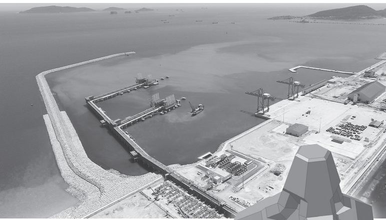
写真1 ベトナム・ニソン 製油所防波堤
