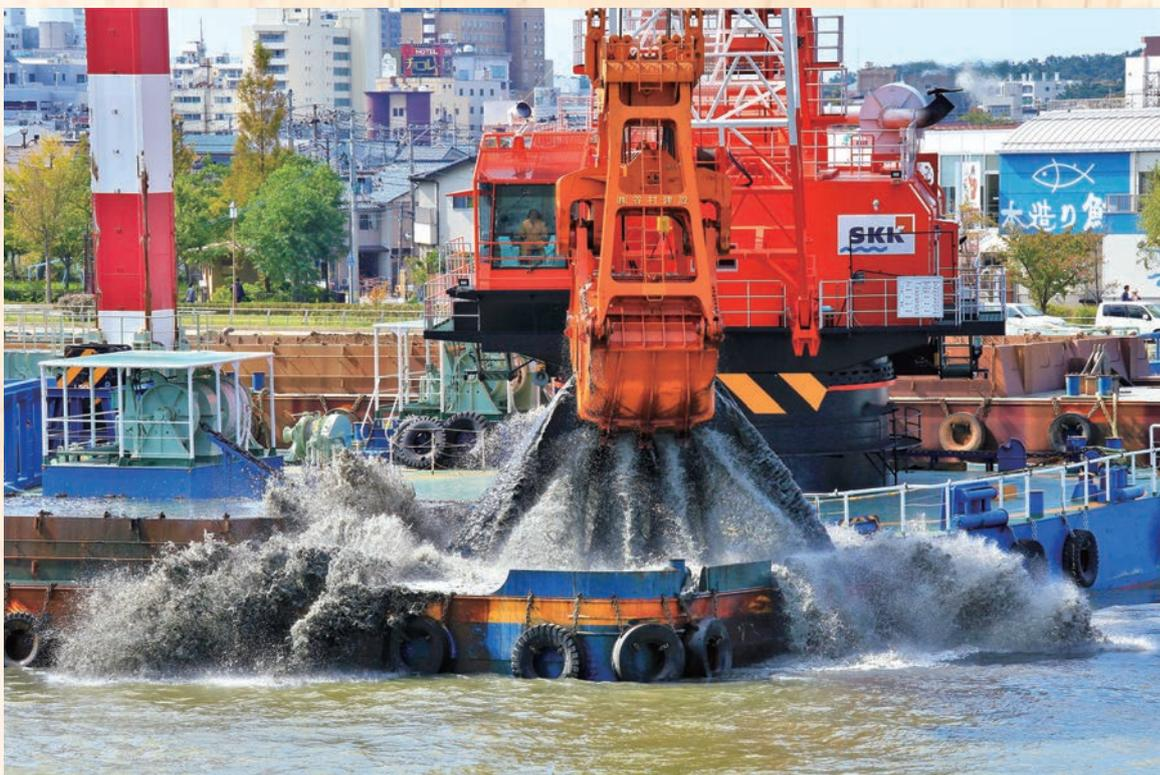
新潟港は二つあり、西港は信濃川河口両岸（中央区と東区）が港域。上流から流れ込む大量の土砂によって水深が浅くなるのを防ぐために、浚渫が欠かせません。その浚渫作業を、銜いなく真正面から端正なフレーミングでとらえています。明るい色調も効果的。掬い上げた瞬間、あふれ流れ落ちる土砂を高速シャッターで写し止め、肉眼ではとらえられない形を切り取っています。
